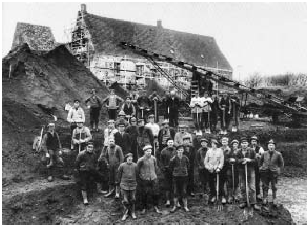
Istandsættelsen af Spøttrup Borg blev gennemført i 1938-1940. Etableringen af voldanlægget blev udført som et beskæftigelsesarbejde for arbejdsmænd.
