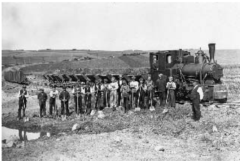
En stor del af jordarbejdet ved anlæggelsen af Skive-Vestsalling jernbane foregik ved håndkraft. Foto ca. 1923.
