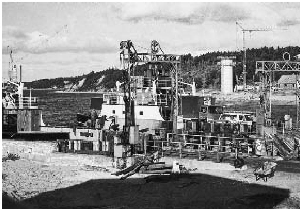
To færger i fæргеlejet ved Sallingsund ca. 1975. I baggrunden ses begyndelsen til Sallingsund-broen.
